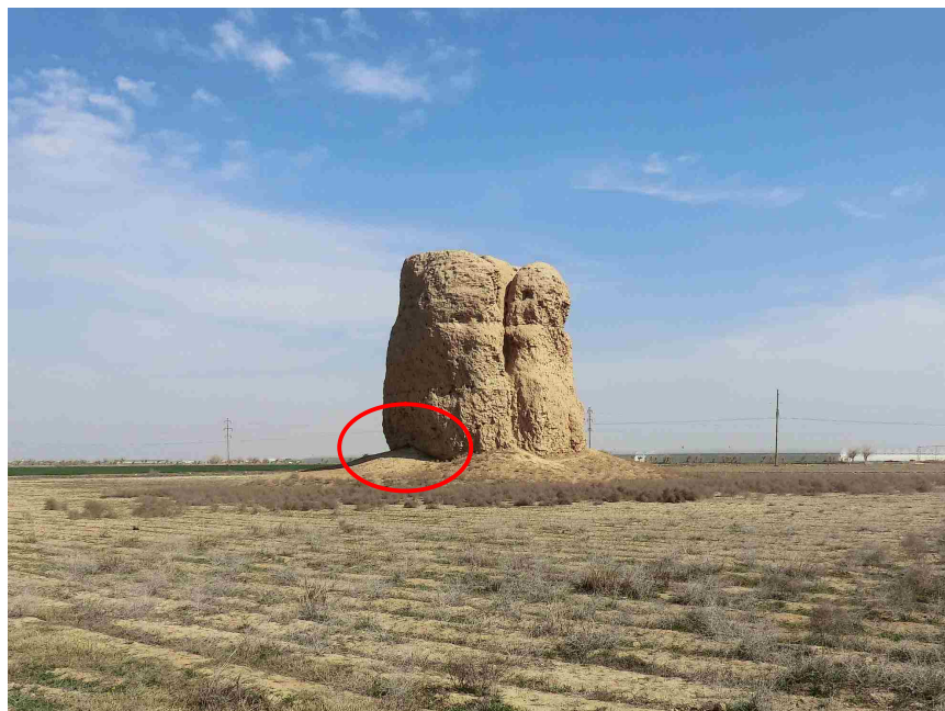
写真 1 仏塔下部の崩壊と傾きの方向
