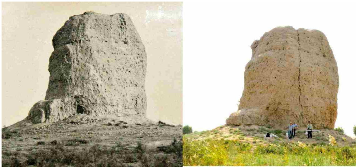
図2 写真の対比からみた亀裂の進行(左:テルメズ考古博物館蔵 1970年撮影、 右:2016年撮影)
