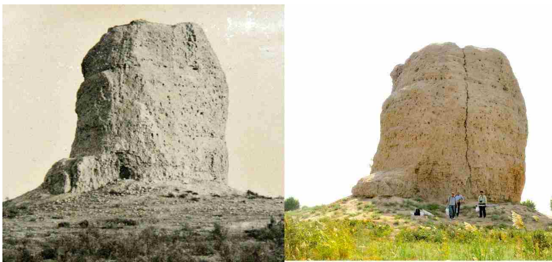
Рис. 2. Разрастание трещины, выявленное в результате сопоставления фотографий (Слева: фотография, снятая в 1970 г. и хранящаяся в Термезском археологическом музее. Справа: фотография, снятая в 2016 г.)
